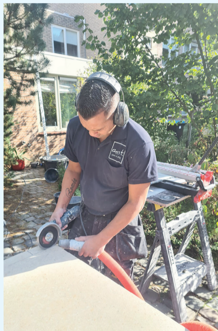
Tegelzetter Nathan Papilaja heeft de Interdynamics Tile Power Premium 125 diamantzaag onlangs getest bij een badkamerrenovatie.
