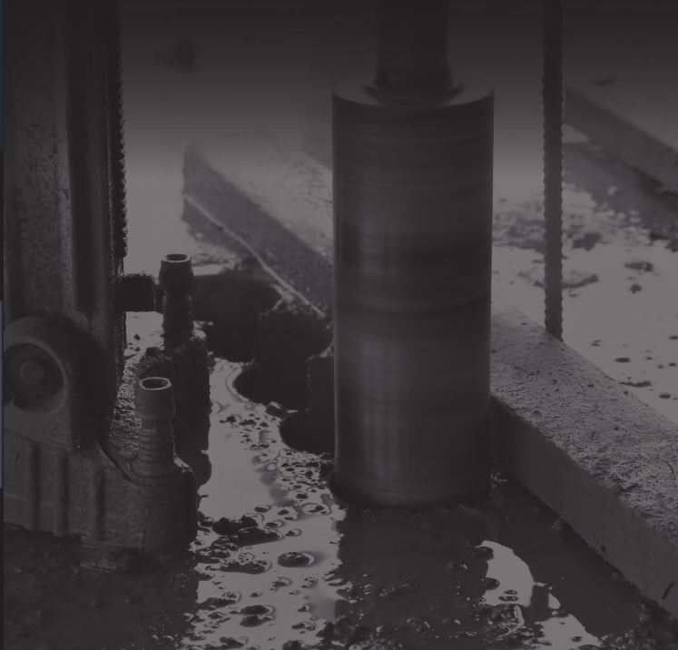
Diamantboren met diverse aansluitingen en diameters variërend van 10 tot wel 300mm.
